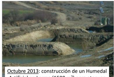
Octubre 2013: construcción de un Humedal Artificial en Lerma (1500 m<sup>2</sup>) para atenuar la contaminación por nitratos del barranco.
